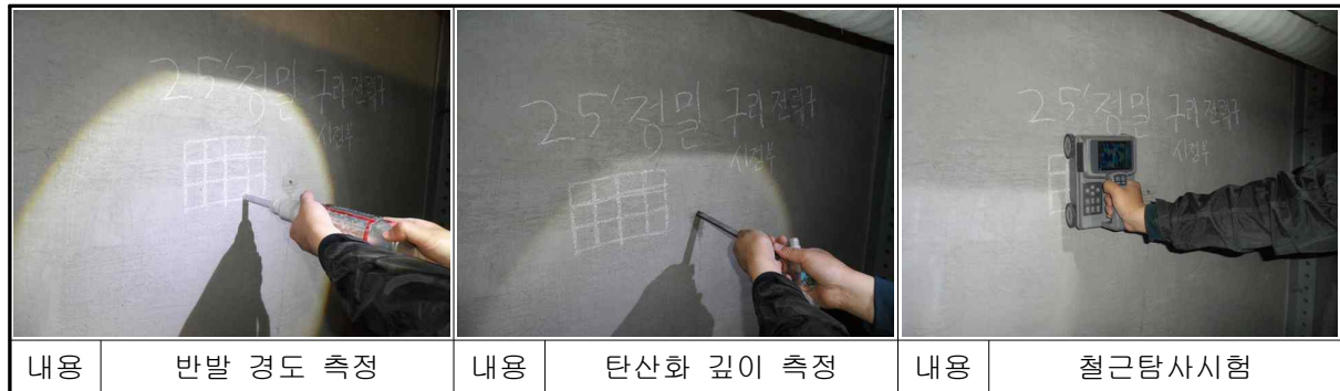
【사진 1.5】 구리인출 전력구 재료시험 전경
